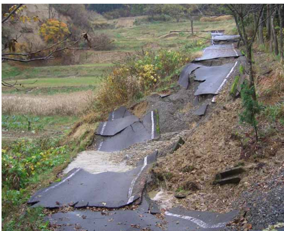
(新潟県中越地震・小千谷地区の道路被害)
